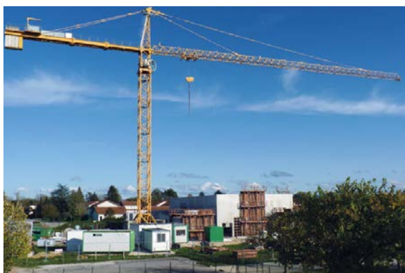
Le chantier vu depuis l'école (16 novembre 2019)
