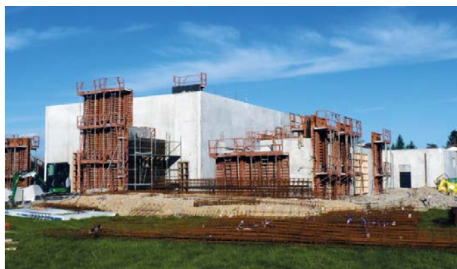
L'ESCALE en cours de construction. Vue sud-ouest
