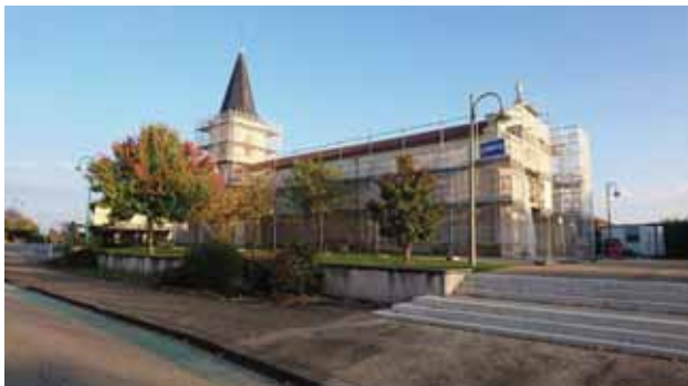
Le chantier de rénovation de l'église.
